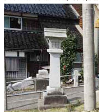
神社の石灯籠が倒壊した
