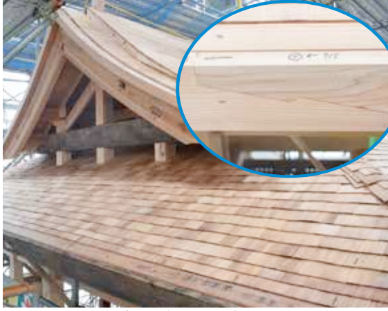
黒い梁が江戸時代からの部材の再利用分
