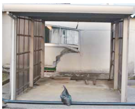
縦方向に亀裂が入った渡り廊下と仮設の下水道パイプ(手前)
