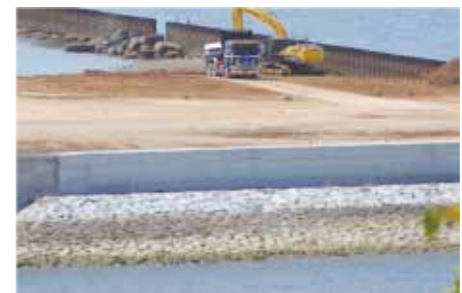
チツソが寄贈した道路の沿岸を約50×400m埋め立てている
