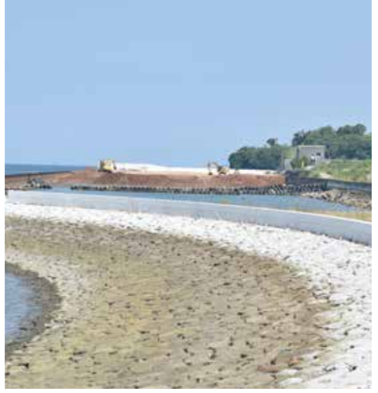
埋立地(上写真)に施された頑丈な護岸
