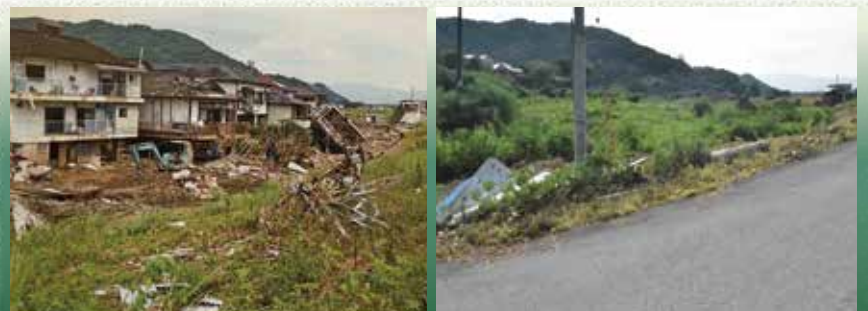
被災直後の茶屋集落(左)(球磨村七十九集落巡りより引用)と住宅が撤去された現在の同地点(右)、フレーム右側には仮橋の相良橋
