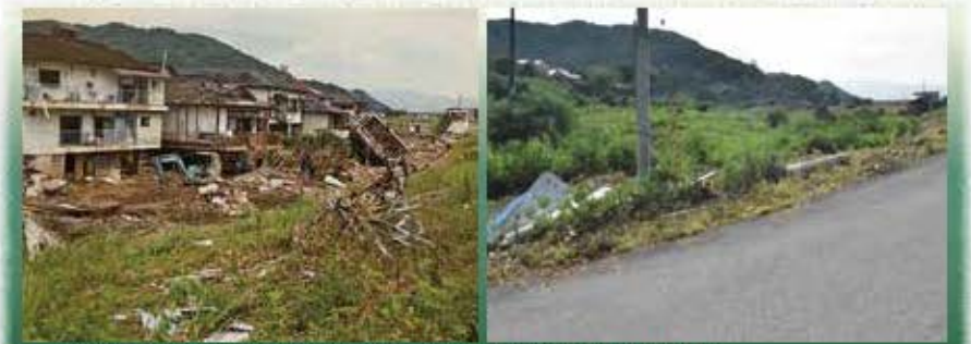
被災直後の茶屋集落 (左) (球磨村七十九集落通りより引用) と住宅が撤去された現在の同地点 (右)、フレーム右側には仮設の相良養
