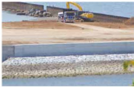
チツソが毒化した道路の沿岸を約50×400m埋め立てている
