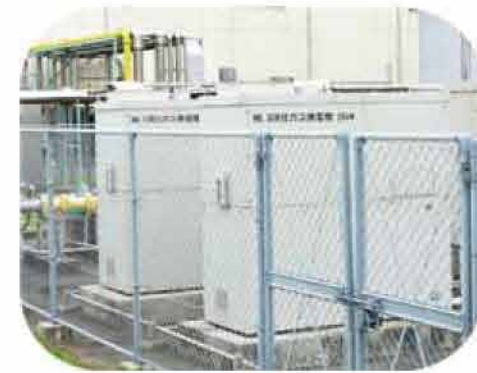
下水処理で生じたバイオガスの発電機。それを人間が食べて排出する。リンは畜養化の原因物質だ。博多湾の赤潮の発生を防ぎ水質保全に努めるため、福岡市道路下水道局は、リン除去高度処理施設を導入している。福岡市は、平成8年からリンを回収
