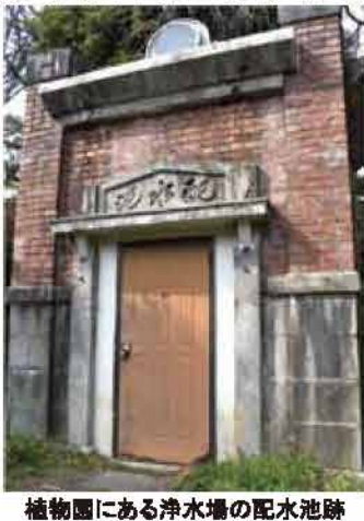
植物園にある浄水場の配水池
