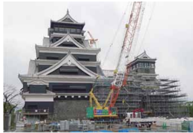
外観が修復された大天守
